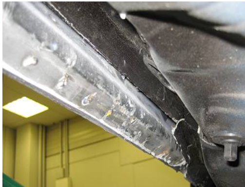
Bild 24: Abriss der WPS-Naht 2. Versuch (von unten)
